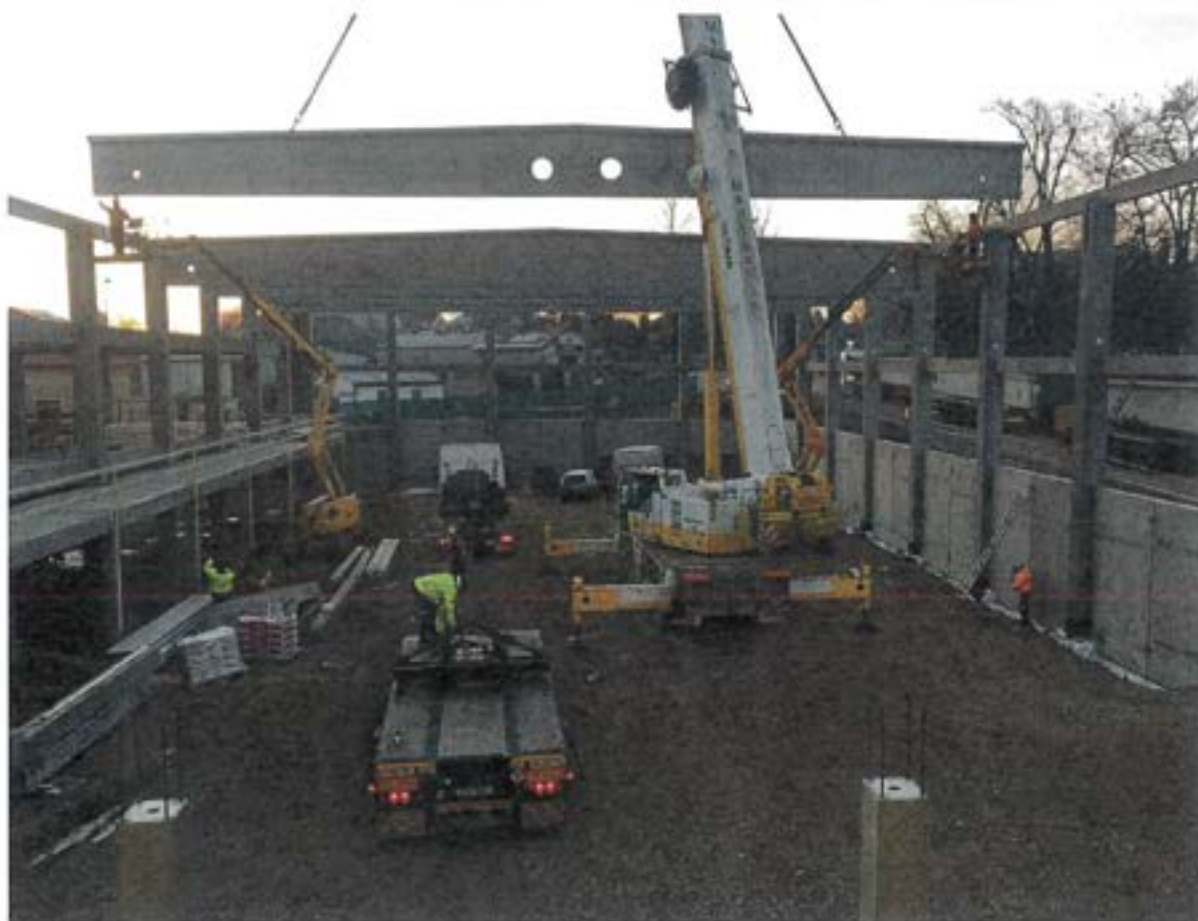
Instalace třicetimetrových nosníků
