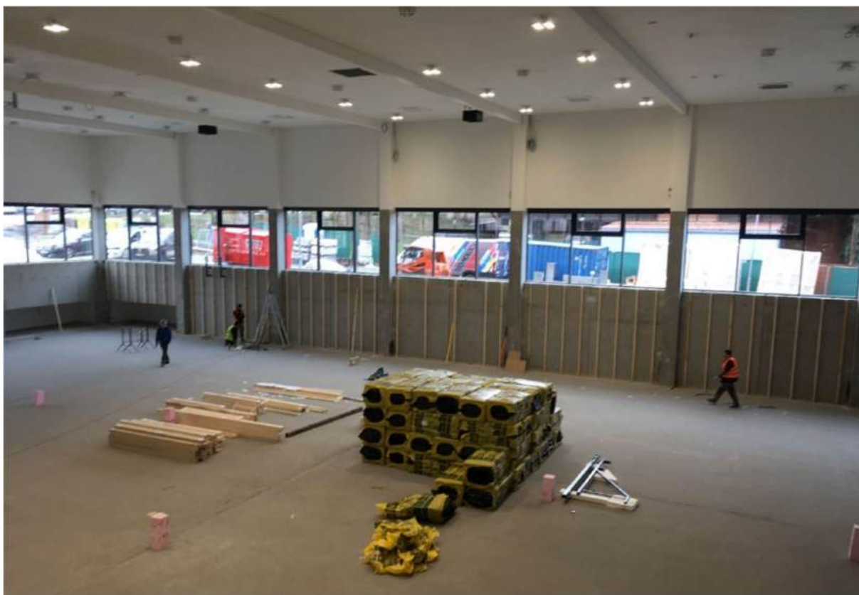
Stavba nové tělocvičny probíhala celý rok
