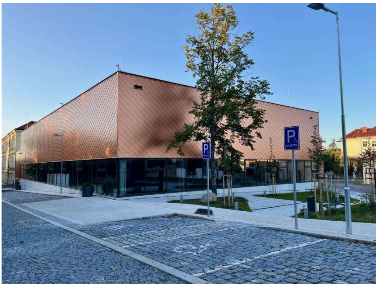
Nová tělocvična těsně před dokončením
